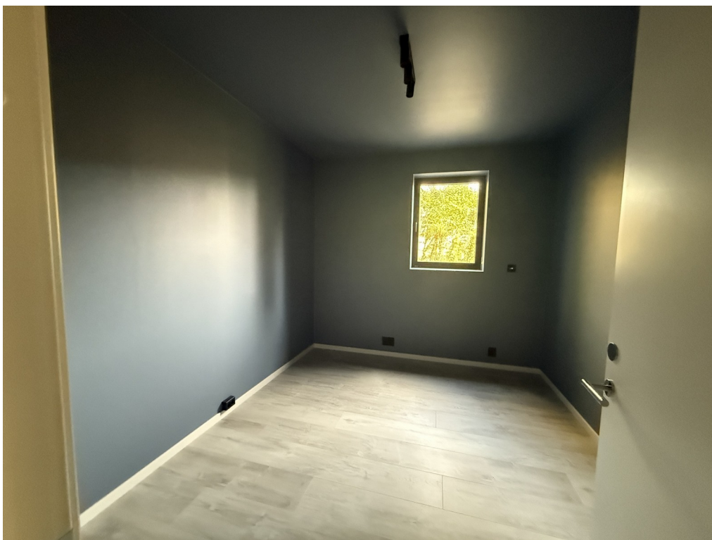
Soverom under hovedetasjen, vist i originalrapportens trinnlyddel.
